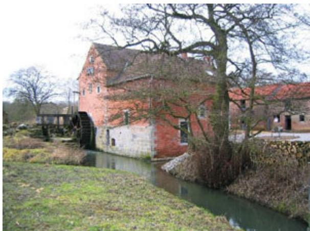
Situé un peu à l'extérieur du centre de Hollogne, le moulin seigneurial est encore pourvu de sa roue à aubes. Ce moulin castral (1646) fait partie d'un ensemble comprenant le château seigneurial (1652) et la brasserie seigneuriale (1753). Lors de la construction du moulin, le Geer et ce qu'on appelle le faux Geer furent détournés et leurs eaux dirigées vers un réservoir. Un système de vannes permit le fonctionnement du moulin.
